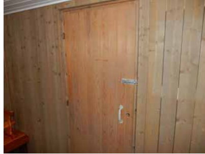
Veden pääsulku sijaitsee keit- tökeskuksen teknisessä tilassa
